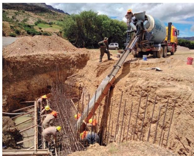
*Imagen 4. Vertido del hormigón a una altura no mayor a un metro.*
