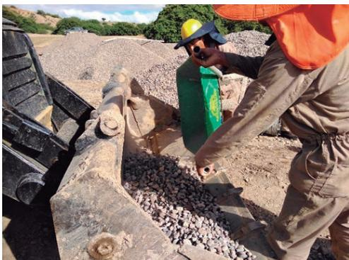
*Imagen 2. Vertido al balde de la Retroexcavadora según cantidad por ciclos.*
